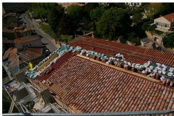
La toiture avec ses différentes protections
